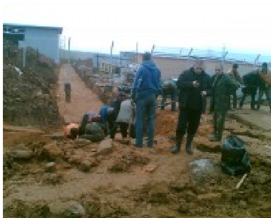
Прокладка кабеля в трубы
