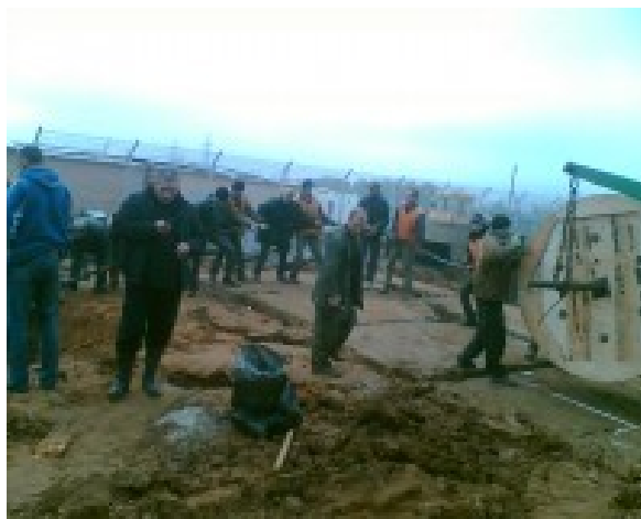
Монтаж кабеля в трубы
