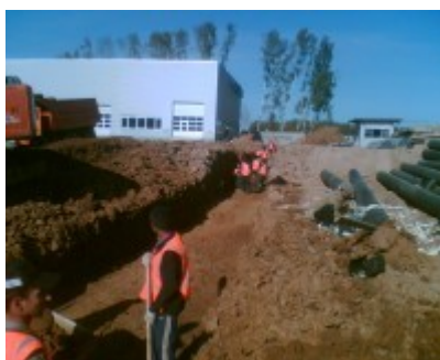
Прокладка кабельной трассы
