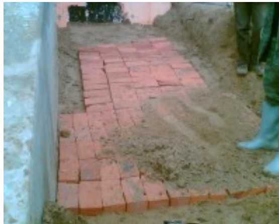
Защита кабельного поворота кирпичём
