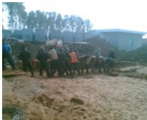
Затягивание кабеля в трубы
