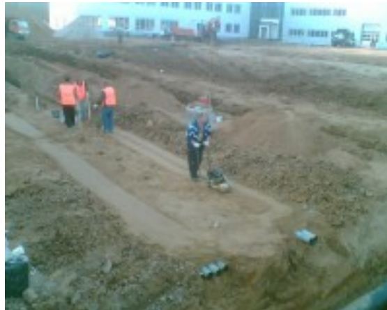
Утрамбовка песка виброплитой
