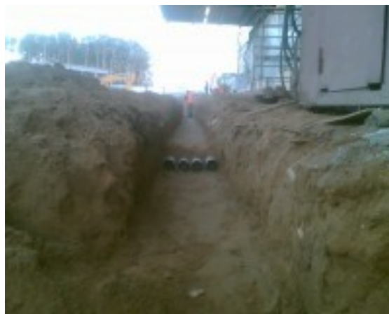
Укладка труб для прокладки кабеля в земле
