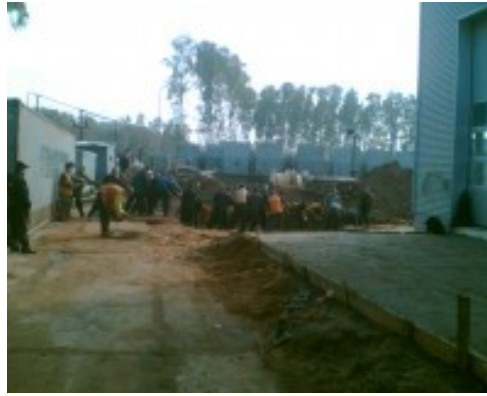
Монтаж кабеля в трубы
