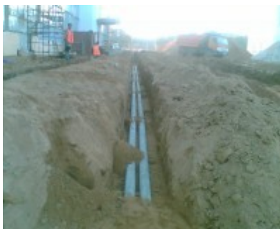
Монтаж труб для прокладки кабеля
