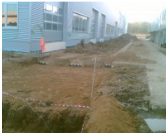
Площадка для поворота кабеля в земле
