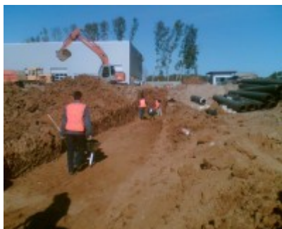
Монтаж кабельной трассы
